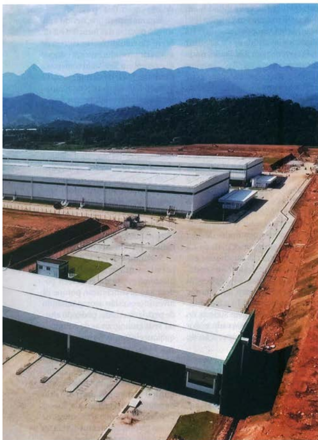
Novo galpão da GLP em Duque de Caxias, no Rio
